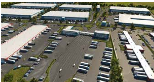
Оптово-распределительный центр «РусАгроМаркет» Новосибирская область Год оснащения: 2020
