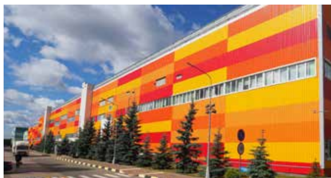
Завод по производству вакцины, ОЭЗ «Технополис «Москва»», Год оснащения: 2020
